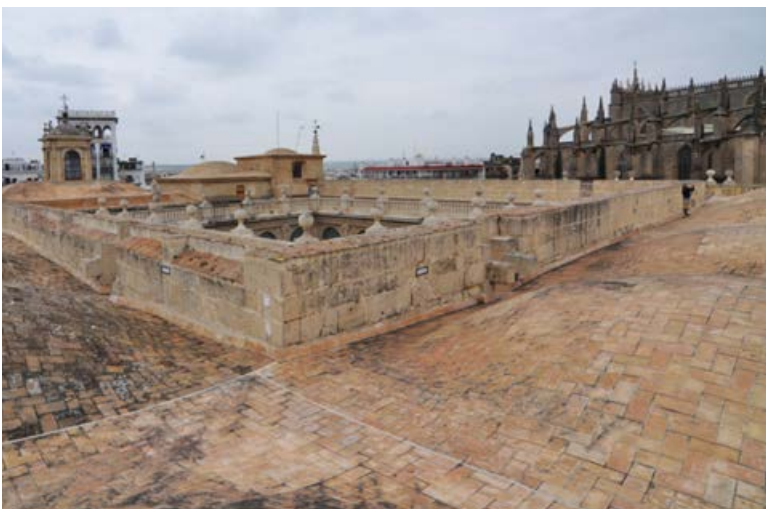
Fig. 8b. Vista interne delle gallerie del piano superiore (foto di José L. Filpo).
